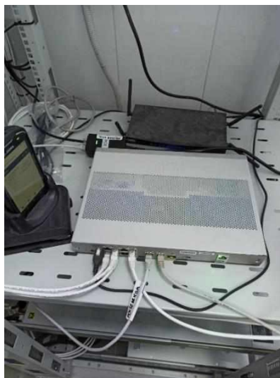
11.8. Фото подключения PoE в электросеть и включение патч-корда в оборудование заказчика.
